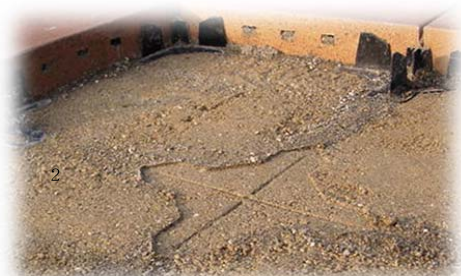
噴出しを抑制した供用後の敷砂状況
