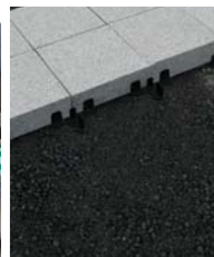
境界石150/300/80 ④強化板工法
