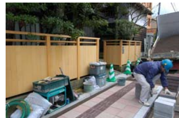
③平板+強化板の敷設
