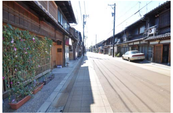
パラペイ(パラレルペイブメント)事例 石川県小松市 町家まちなみ保存道路改修工事
