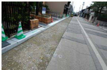
①側溝の設置 平板舗装部掘削
