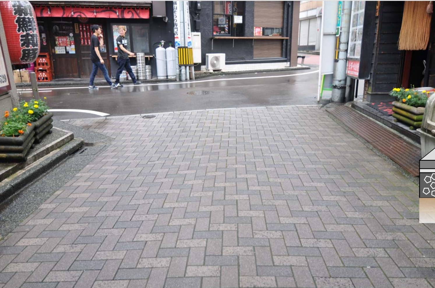
性能の高い網代張りでも交差点や駐車場出入り口ではズレ防止用の強化板を挿入。
