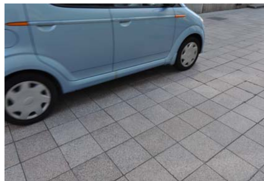
補修後、8年。舗装は、いまなお健全な状態を維持している。
