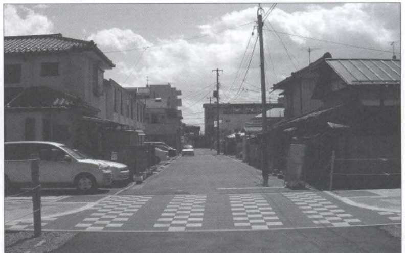
福島市内の透水性平板による車道事例
