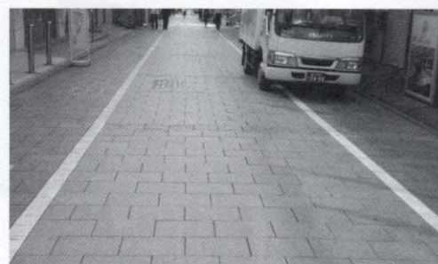
写真 3.1 自由が丘マリクレール通り天然石舗装の事例
