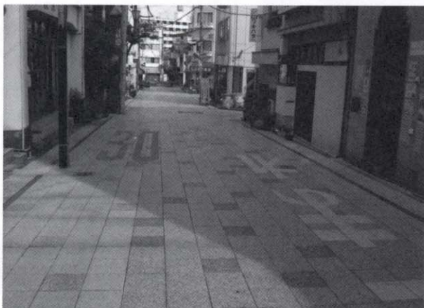
熱海市内の透水性研磨平板による排水性舗装の事例
